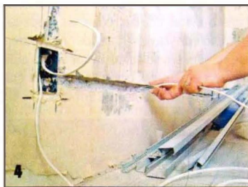
Закрепление провода в штробе при помощи дюбель-скобы.
