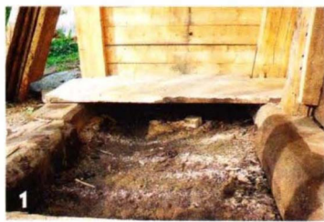
1 Фундаментом для летнего душа служат шпалы. Такой же фундамент делаем и для сарайчика-пристройки.
