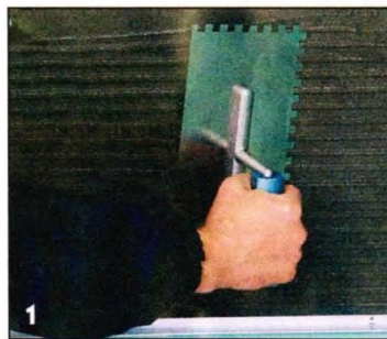
Плиточный клей после нанесения на основание разравнивают зубчатым шпателем.
