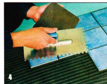
При укладке плитки на пол клей наносят и на основание, и на плитку.
