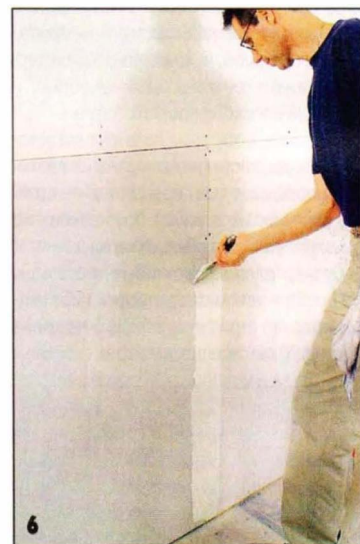
Заделка швов в местах стыка листов гипсокартона.
