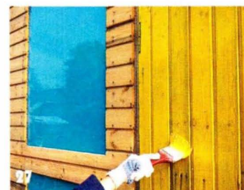
После обработки поверхностей хозблока грунтовкой, приступили к их окрашиванию.
