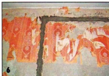
После укладки провода, штробу заделывают алебастром или строительным раствором.
