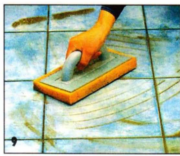
Пока затирочный состав не высох, его излишки удаляют влажной губкой или с помощью тёрки, которая подбита губкой.
