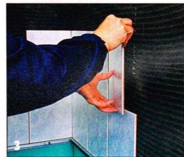
Нижний ряд плитки на вертикальных основах устанавливают на специальную опорную (одновременно и направляющую) планку.
