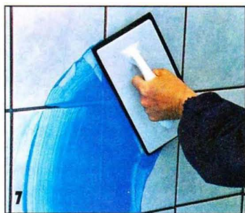
Затирка швов при вертикальном покрытии.
