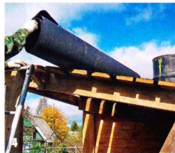
Прежде чем покрывать крышу шифером, на обрешётку настелили пергамин. Последний послужил ещё и временным укрытием деревянной конструкции от дождя.
