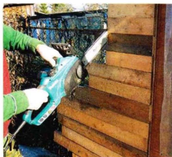
14 Цепной электропилой срезали «хвосты» досок, выступающие за внешней угол.
