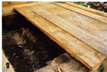
2 Непосредственно на шпалы уложили доски чёрного пола.
