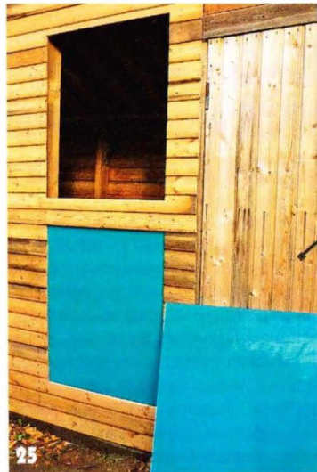
Изнутри душевой кабины вставили стёкла, прижав их к внешней деревянной обшивке с помощью реек.
