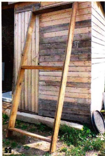
По размеру проёма передней стены душа собрали из досок каркас-раму.
