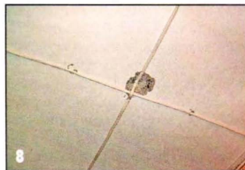
Укладка проводов по потолку (под облицовку).
