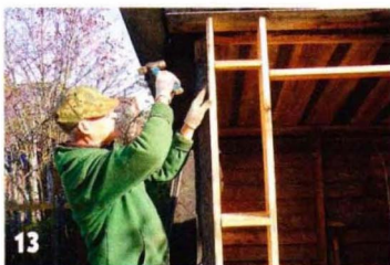
13 Распорки, обеспечивающие жёсткость конструкции, одновременно являются полками для мелких вещей.
