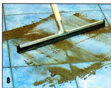
При затирке швов между плитками, уложенными на пол, можно применить широкий резиновый скребок.
