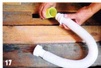
17 Выведенный из-под пола сливной шланг соединили с патрубком гофрированного сифона.
