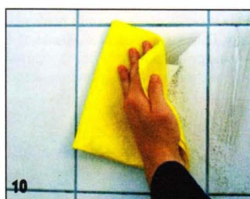
Финишная очистка поверхности облицовки из керамической плитки.
