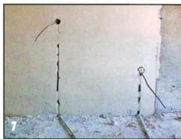
Укладка проводов в трубах под стяжку.
