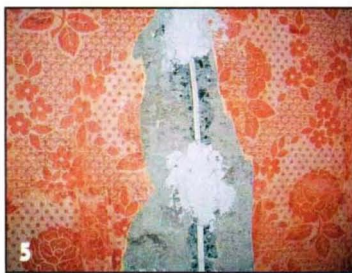
Закрепление провода в штробе алебастровыми нащёлками.
